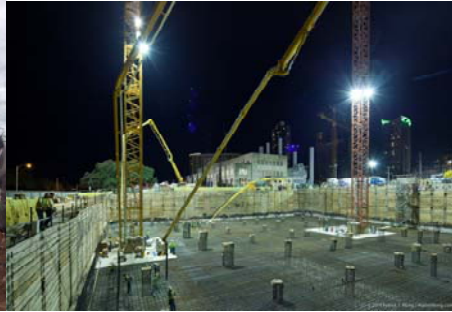
NCL - Mat Slab Pour
